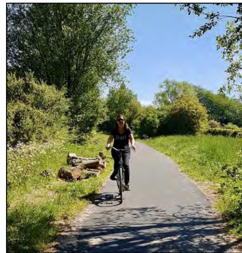
Revêtement en enrobé
